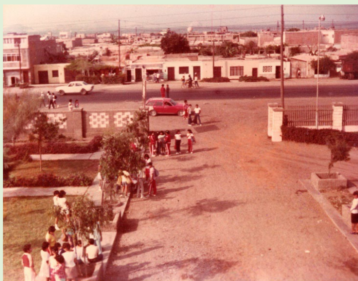
Vista tomada desde el segundo piso del colegio demostrando la Av. Meiggs y el pasaje Jr. Kennedy.
