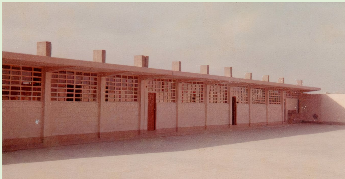
El patio principal mostrando el pabellón de aulas de la izquierda con un solo piso construido, y, al fondo, el muro en la calle Almte. Guisse.
