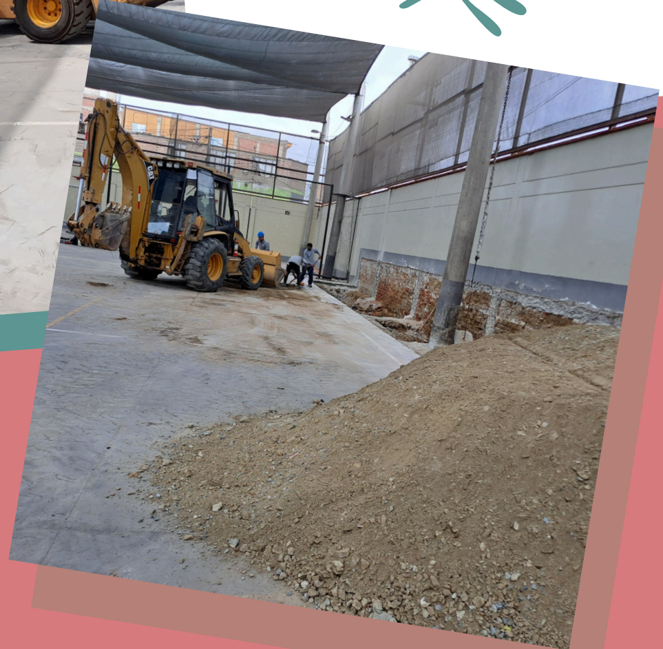
Demolición de la tribuna de concreto (Jr. Fray Martín)
