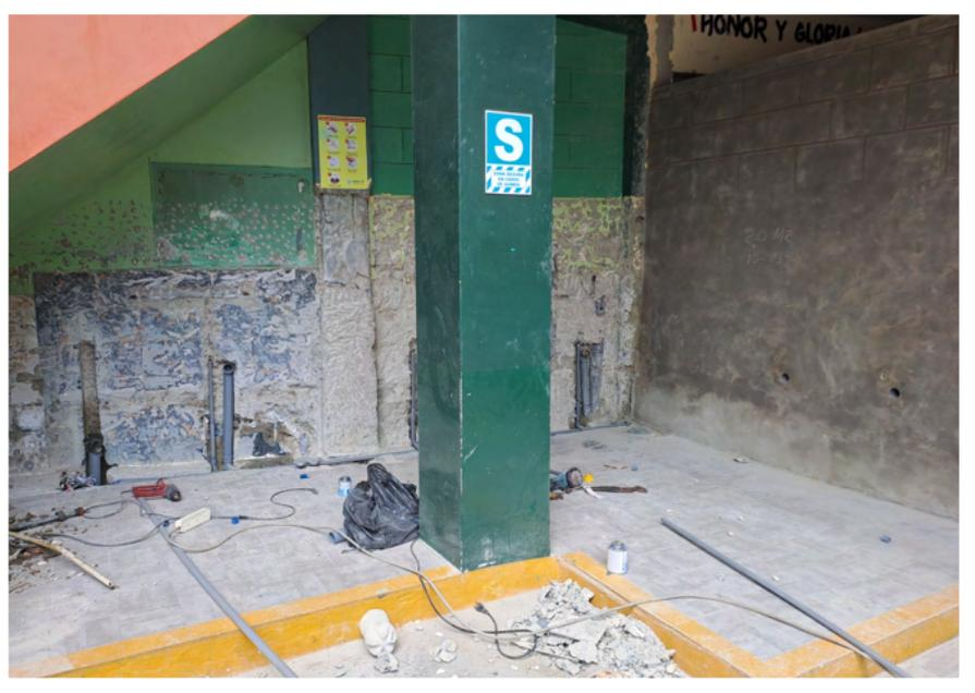
Se aprecian las conexiones de agua y desagüe, y el comienzo del enchapado de las paredes con cerámicos.
