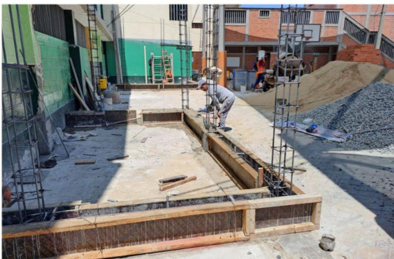
El encofrado para las vigas de cimentación o sobrase.
