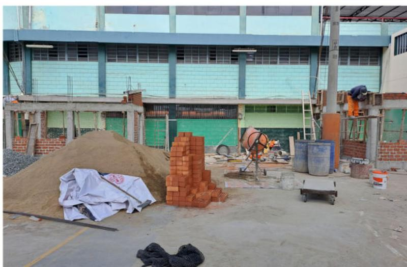
Avanza la construcción de las vigas, columnas y base para el techo de planchas termoacústicas.
