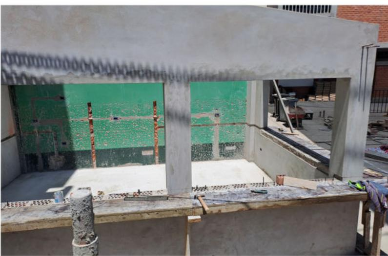
El kiosco 2 con las encimeras de servicio exterior armadas y vaciadas.
