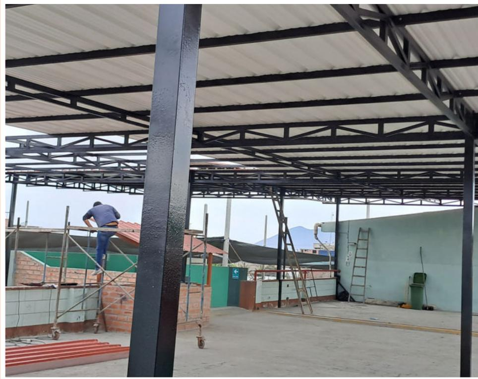
Con motivo de proteger los techos planos de daños causados por la precipitación, se han instalados dos techos de planchas termoacústicas.
