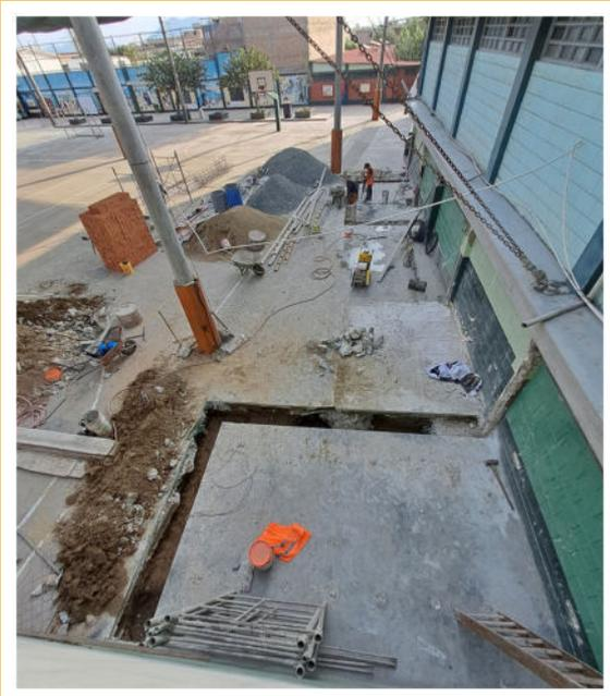
Vista aérea de la excavación para colocar los cimientos.
