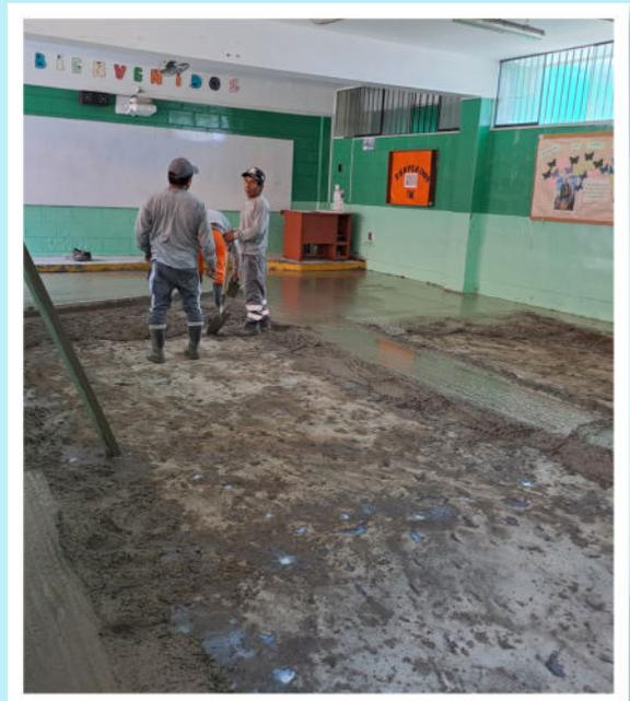
Acción del vaciado de concreto para la losa nueva.
