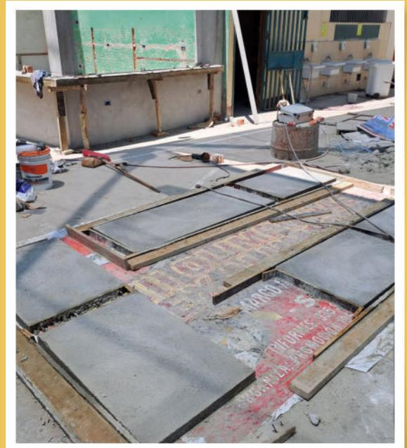
Los paneles de concreto armado que servirán como encimeras dentro de los kioscos
