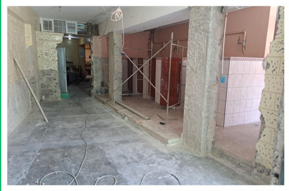
Con la pared demolida, se ve la zona amplia donde se instalarán los diez inodoros adicionales.
