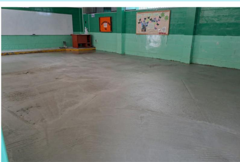
Con el vaciado completo, la losa descansa antes del pulido final.
