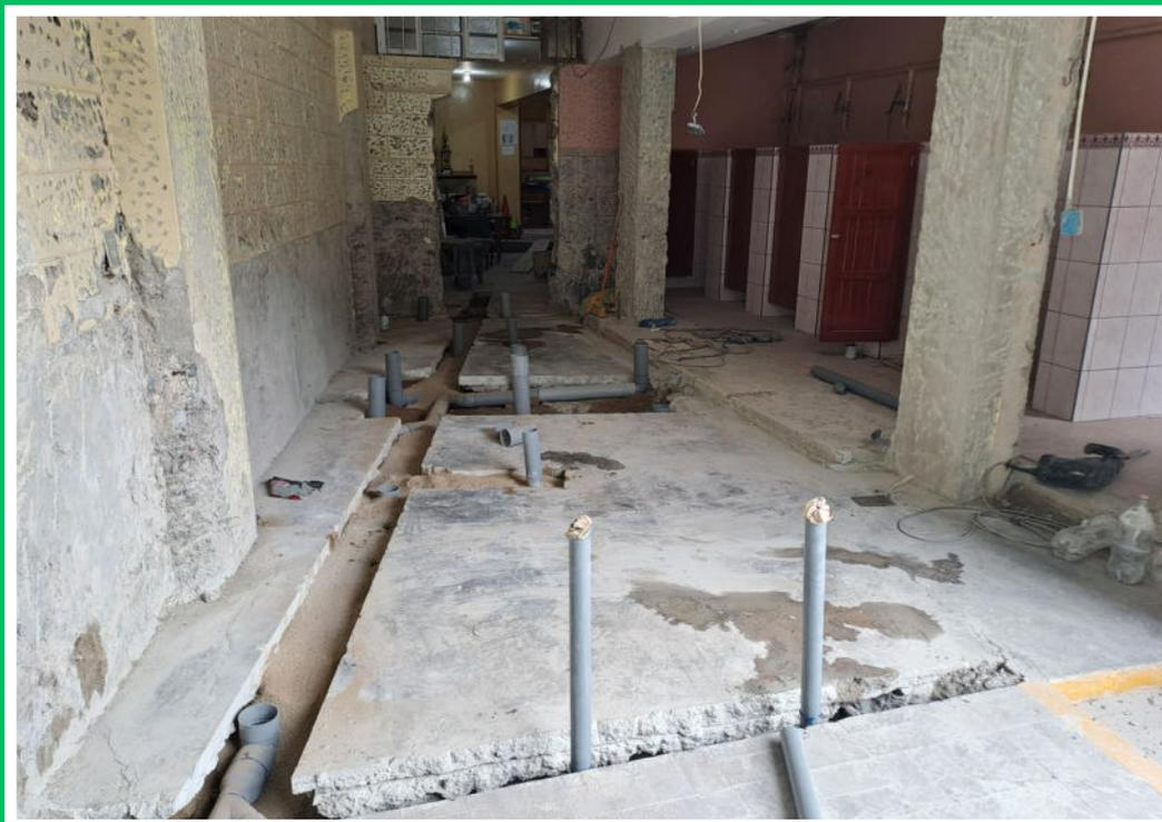
Colocación de la tubería de desagüe para los 10 inodoros adicionales.
